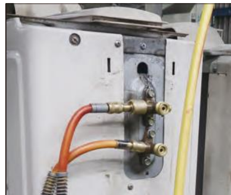
エアコンの室外機から冷媒フロンを回収する様子
